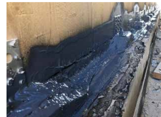
CLT-wanden aansluiten op beton Luchtdichte overgang tussen CLT-elementen en bijv. betonplaten. Ook complexe vormen (bijv. hoekprofielen). De bovenste laag van de elementen moet hiervoor luchtdicht zijn. Onregelmatige mortels kunnen gewoon worden overgespoten.
