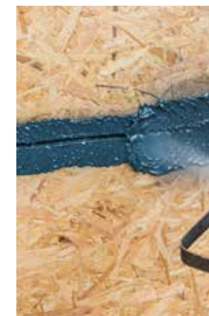
Voegen en scheuren tot 3 mm dichtmaken Scheuren en voegen eenvoudig dichtspuiten of dichtsmeren. De gebrekkige plekken hiervoor rijkelijk met AEROSANA VISCONN bedekken en daarna overspuiten.
