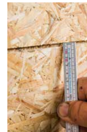
Voegen en scheuren tot 3 mm dichtmaken Scheuren en voegen eenvoudig dichtspuiten of dichtsmeren. De gebrekkige plekken hiervoor rijkelijk met AEROSANA VISCONN bedekken en daarna overspuiten.
