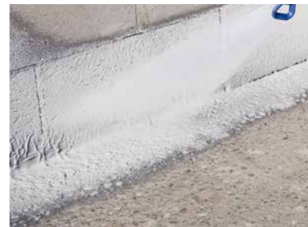
Niet-bepleisterde wanden of beschadigd pleisterwerk afdichten Niet-bepleisterd metselwerk luchtdicht maken.
