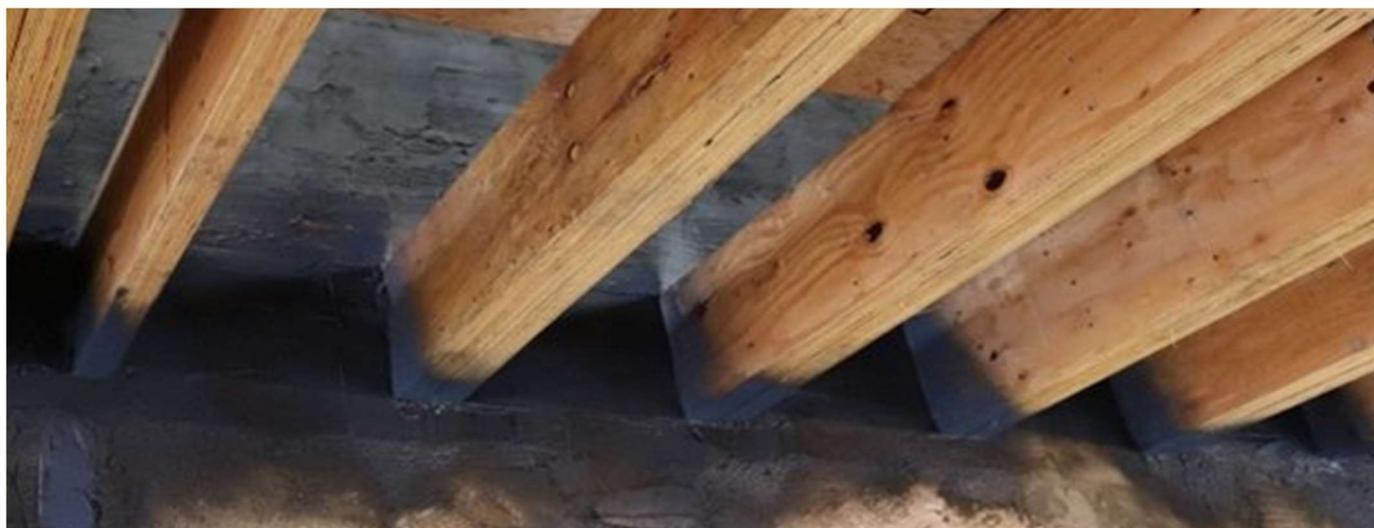
Figure 13 : étanchéification autour et entre les gîtes avec pro clima AEROSANA VISCONN (FIBRE)
