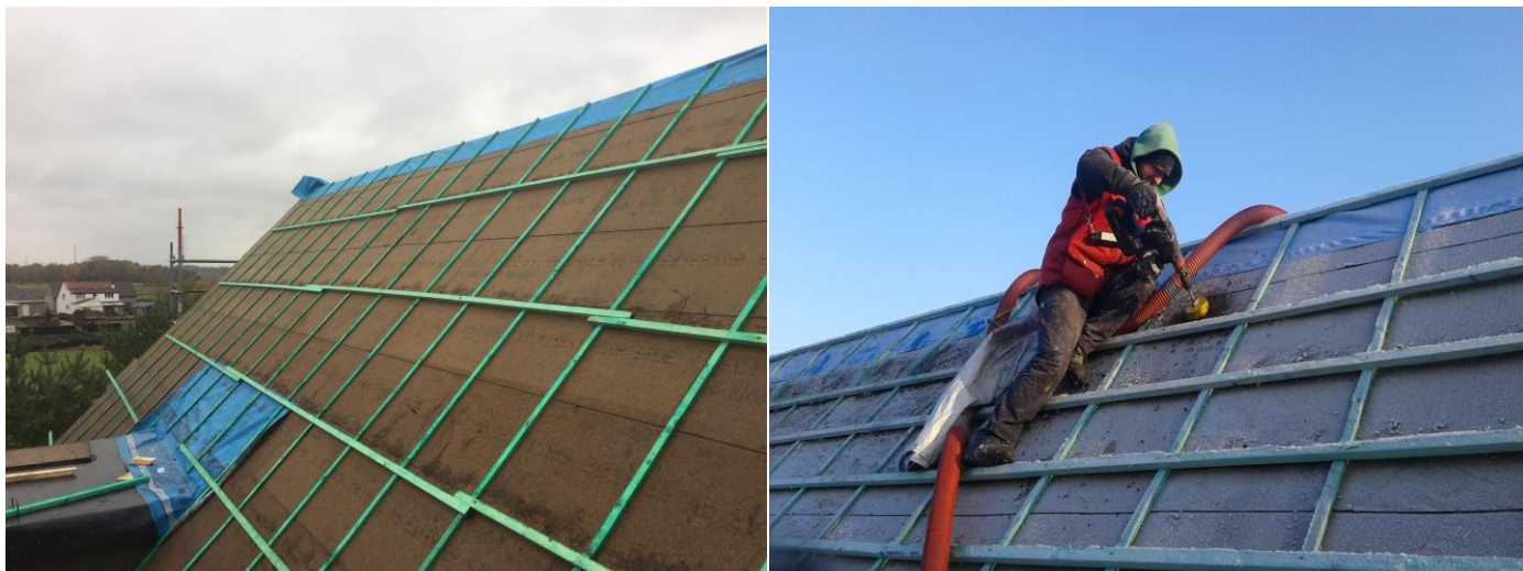
Figure 11 : Isolation sarking avec cellulose iQ3 – chevrons autoportants. Chantier exécuté par DaServ!cio à Haacht.
