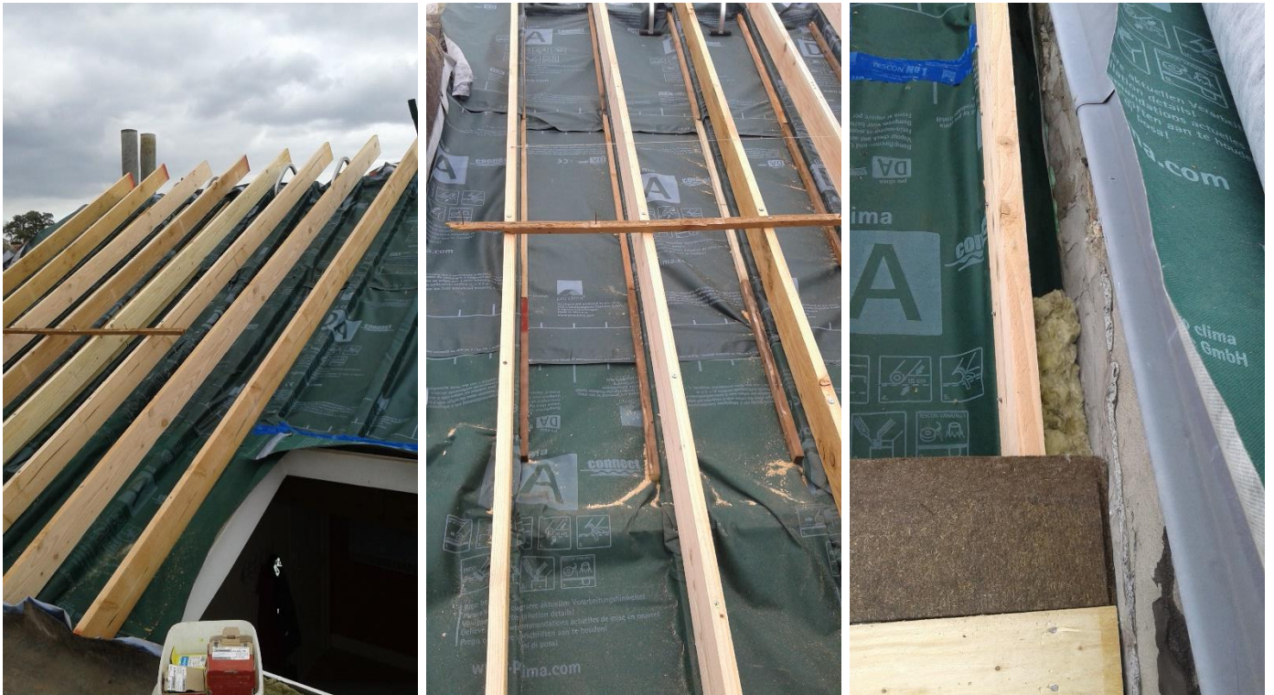
Figure 18 : Isolation sarking avec cellulose iQ3. Chevrons porteurs avec vis à distance.
