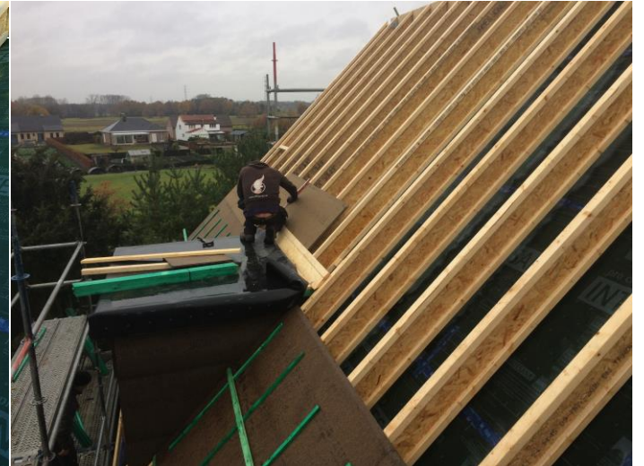
Figure 10 : Isolation sarking avec cellulose iQ3 – chevrons auto-portants ; coupes longitudinale et transversale.
