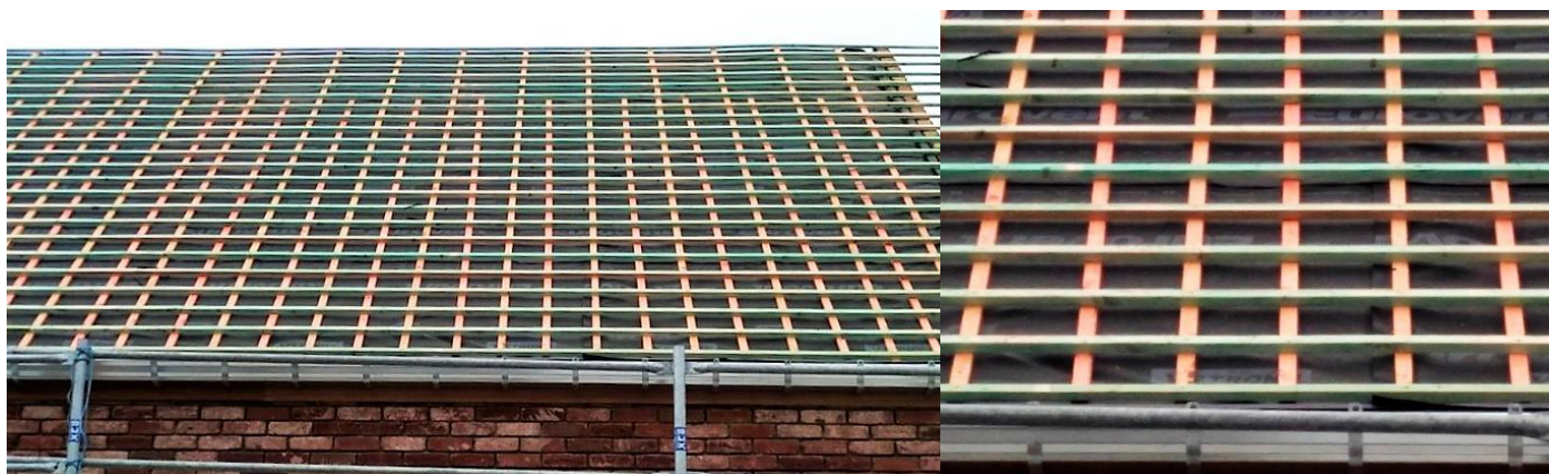
Figure 1 : Toiture avec sous-toiture souple et lattes-à-pannes flottantes.
