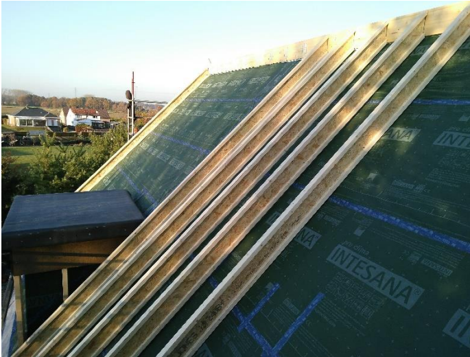
Figure 10 : Isolation sarking avec cellulose iQ3 – chevrons auto-portants ; coupes longitudinale et transversale.
