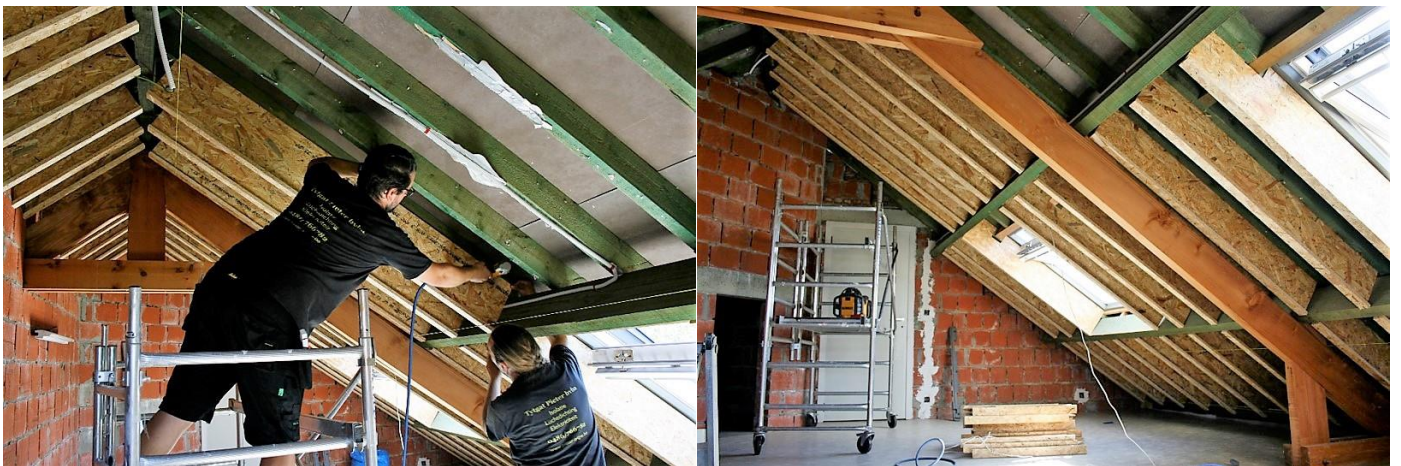
Figuur 6: Het uitdikken van een bestaande dakstructuur met behulp van iQ3-profil. Werken uitgevoerd door Pieter Tytgat bvba.
