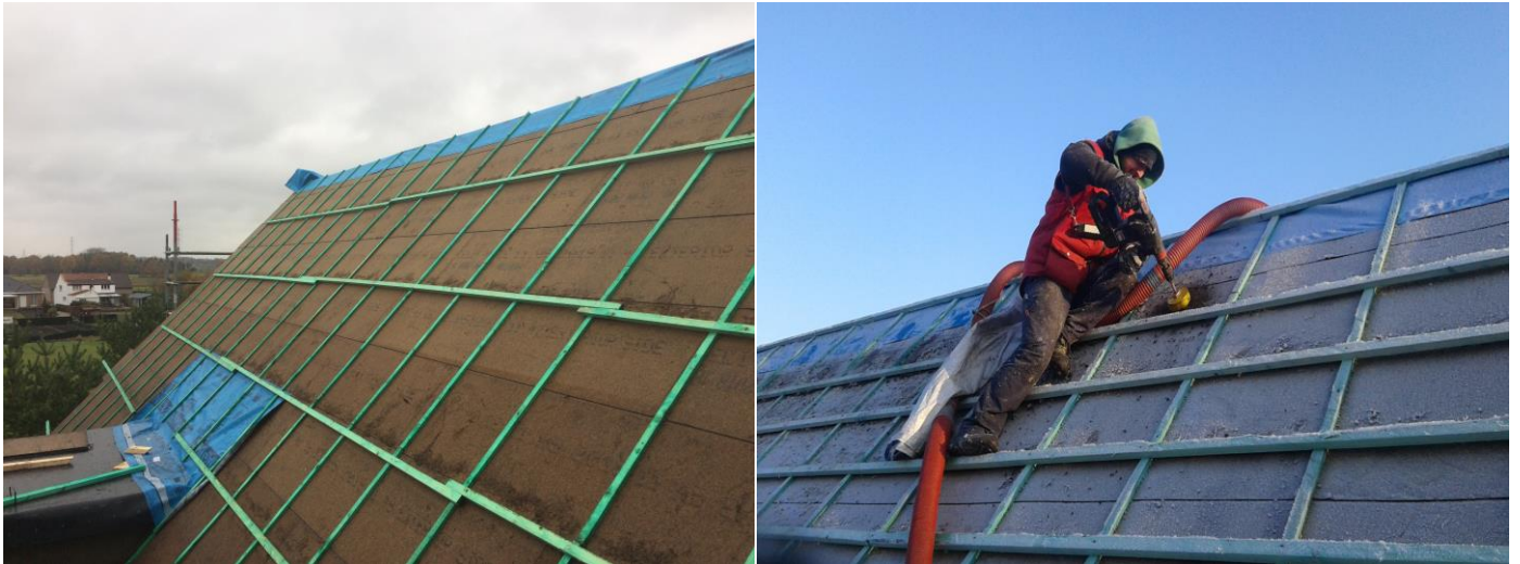
Figuur 11: Sarking renovatiewerf met zelfdragende keperplanken en iQ3 cellulose-isolatie. Werf uitgevoerd door DaServ!cio te Haacht.
