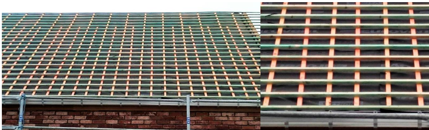
Figuur 1: Dak met een soepel onderdak en zwevende tengellatten tussen bestaande tengellatten.
