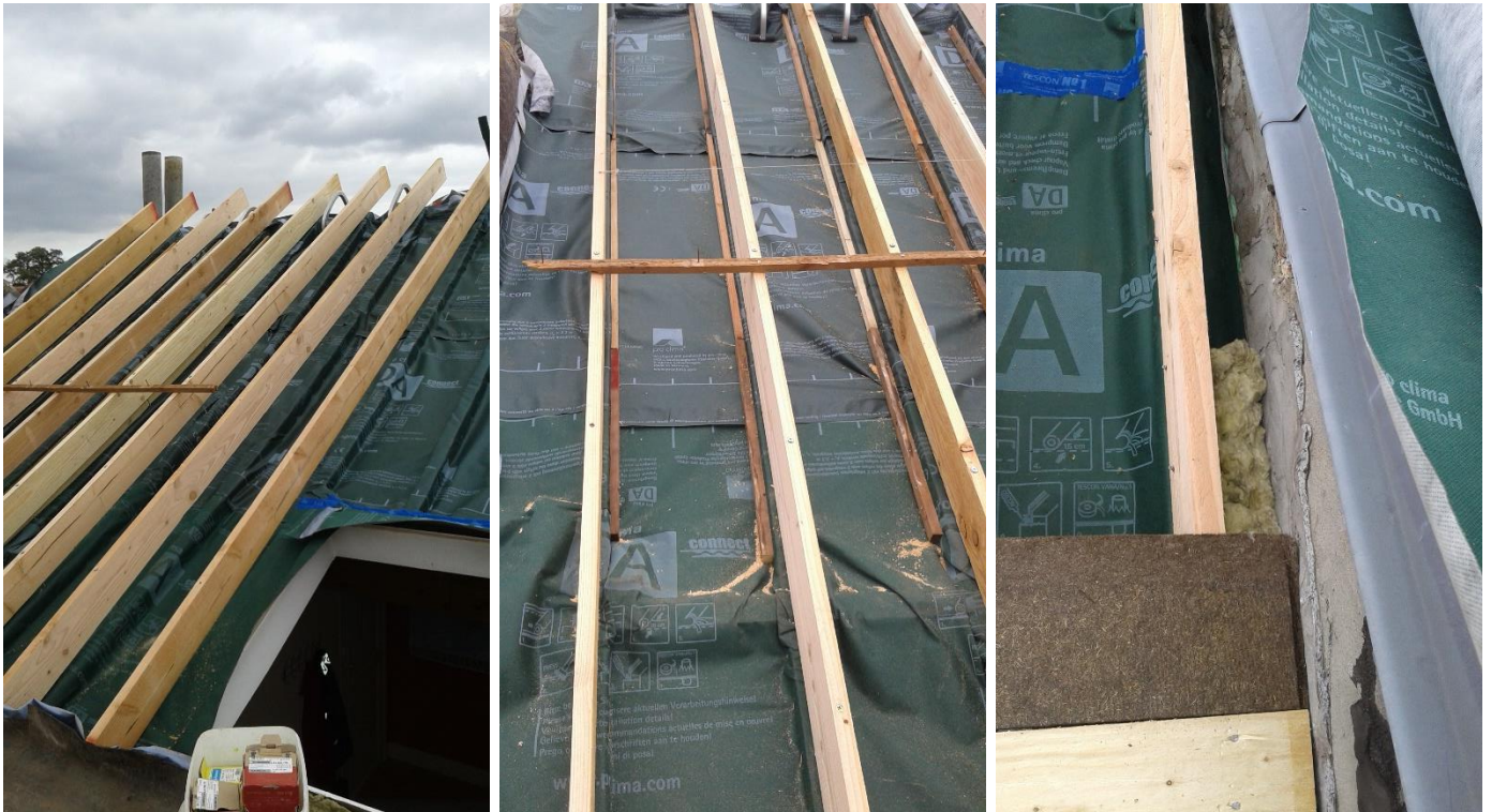
Figuur 18: Sarking renovatieoplossing met iQ3 cellulose-isolatie waarbij zelfdragende keperplanken met afstandschroeven op de bestaande kepers bevestigd werden.
