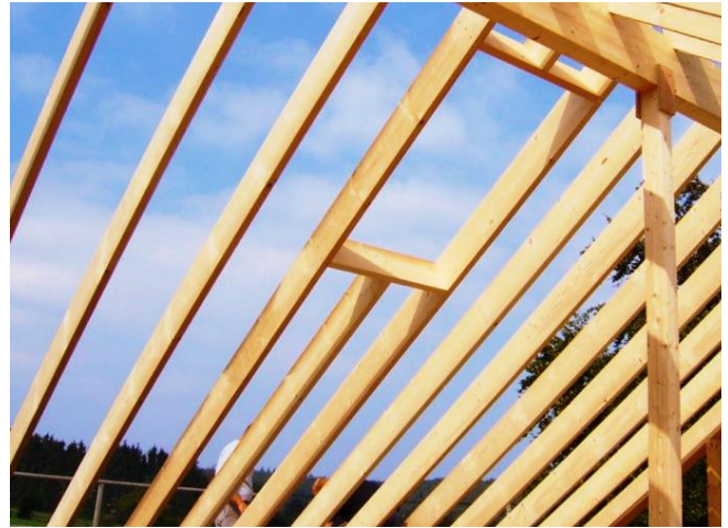
De geplaatste daktimmer voorzien van een raamopening.
