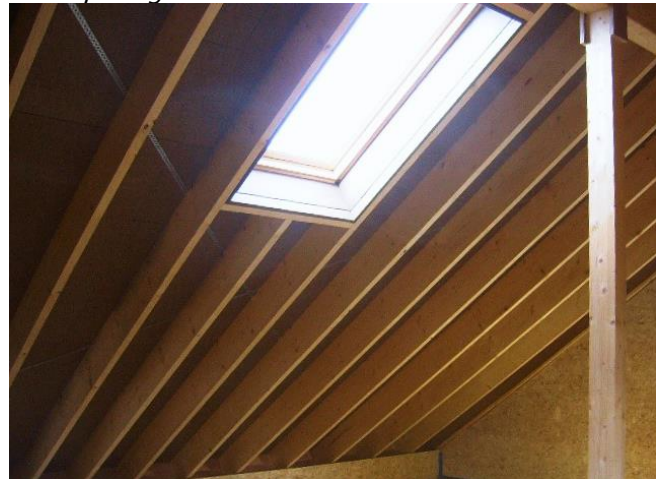
Daktimmer voorzien van bandijzer, onderdak en dakvlakvenster.
