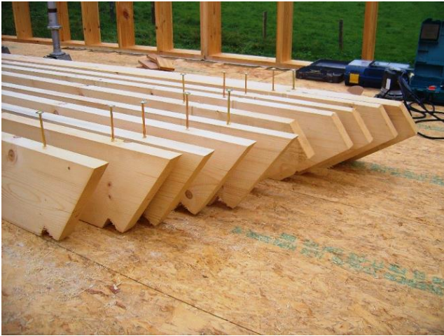
De voorbereide keperplanken liggen klaar en zijn reeds voorzien van schroeven.
