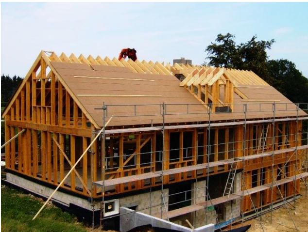
Plaatsen van het Celit 4D onderdak.
